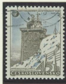
Meteorologische Station in den Karpathen mit Antennen für verschiedene Wellenbereiche
